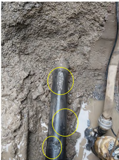
Rohrbruch und weitere Schäden am Rohr
