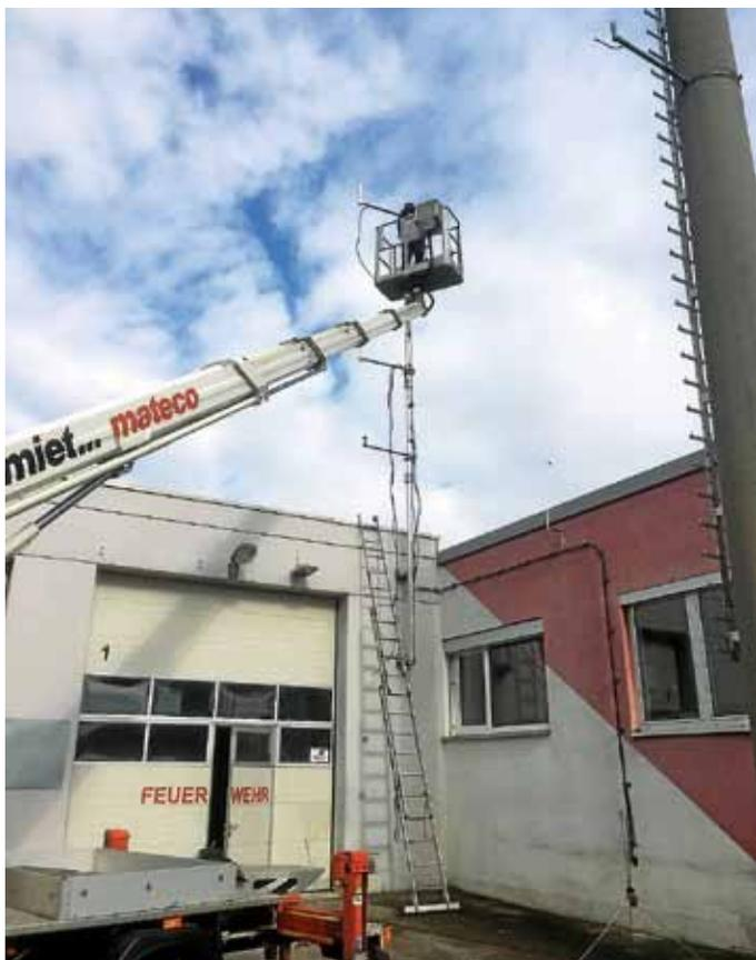
Zunächst wurde der „lange Spargel“ im oberen Teil per Gurt mit einem Kran verbunden, dann wurde am Fuß des Mastes der Beton mit einem Meißel abgetragen und danach die Eisenverstrebung in der Betonhülle durchgeflext.
