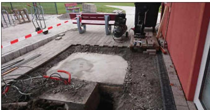
Vorarbeiten im Freibad: Die Fundamente für Drehkreuz und Gruppentür für das neue Kassensystem werden erstellt.
