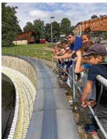
Auf der rechten Seite binden Styroporkügelchen das Fett. Im Vorklärbecken schwimmt alles was leichter ist als Wasser. Was schwerer ist, das setzt sich am Boden ab. Beides wird mit Schiebern entfernt. Im Belebungsbecken werden ganz viele Bakterien eingesetzt. Also wenn Du zwei Hände voll Wasser davon nimmst, hast Du über 1.000.000 Bakterien in Deiner Hand. Das Nachklärbecken ist ein riesengroßer Trichter. Da hinein passen 1.600.000 Liter. Das
