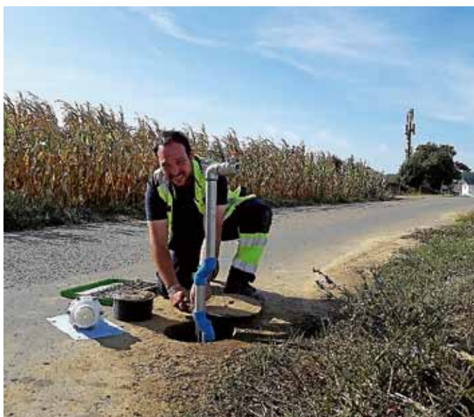
Thomas Röhrich bei der jährlichen Wartung eines Belüfters und Entlüfters einer Wasserleitung
