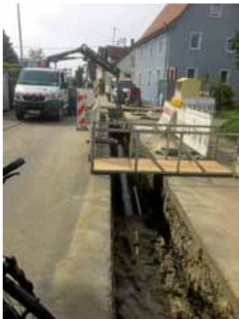
Verlegen von Nahwärmeleitungen in Ilsfeld
