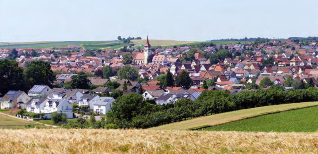
2013 WURDE DAS ILSFELDER NAHWÄRMENETZ GEBAUT, IN WELCHES HEUTE DIE WÄRME DES ABWASSERS GESPEIST WIRD.
